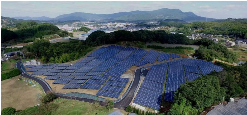
谷川建設第一ソーラー発電所(発電計画容量：1,250.00kw)
