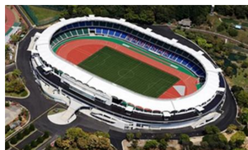
長崎県立総合運動公園新陸上競技新築工事(2 工区)
