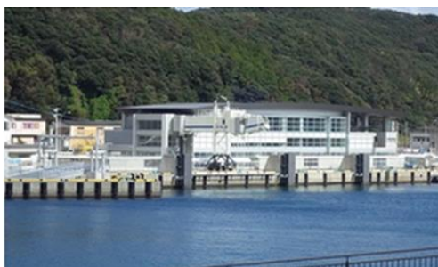
厳原港国内ターミナルビル新築工事(建築主体)
