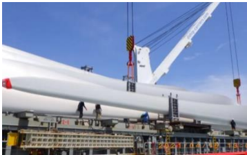
《風車部材 船内荷役作業》
