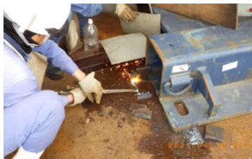
《ガス溶断・溶接作業》
