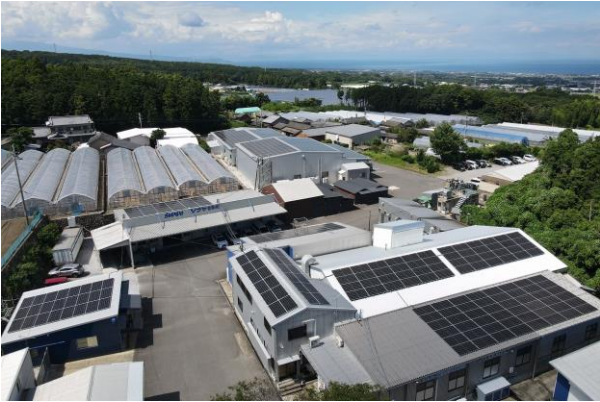
〈本社社屋・本社工場の太陽光発電〉
