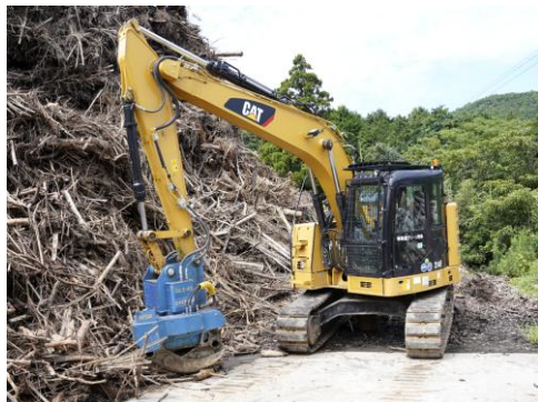
0.45 バックホー（グラブ装置付）3 台
